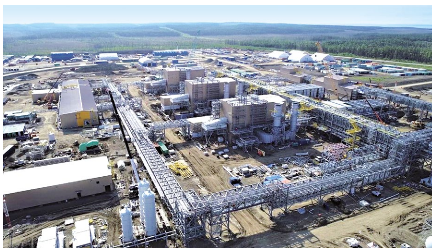
Строительство ДКС ОБТК проекта «Сахалин-2»
