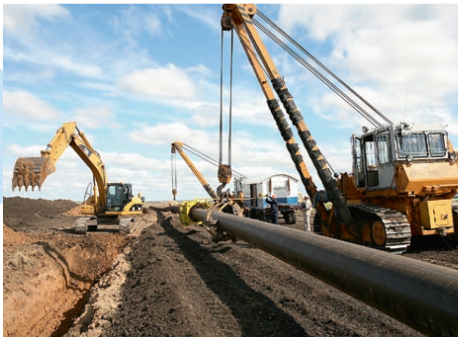
Строительство межпоселкового газопровода
