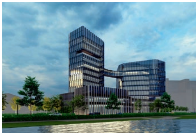
Административно-производственный корпус ООО «Газпром трансгаз Казань»
