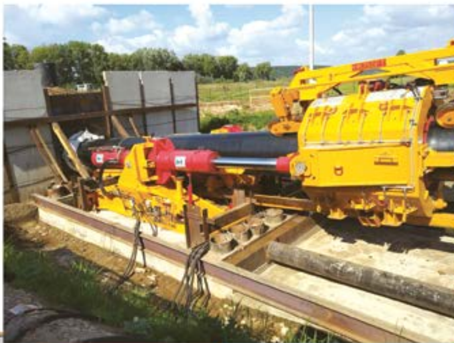
Возведение подводного перехода через р. Каму бестраншейным способом по методу «direct pipe»
