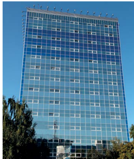
Здание ДОО «Газпроектинжиниринг» 2015 год
