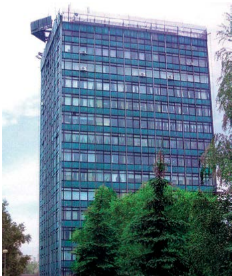
Здание АО «Воронежэлектронпроект» 1995 год
